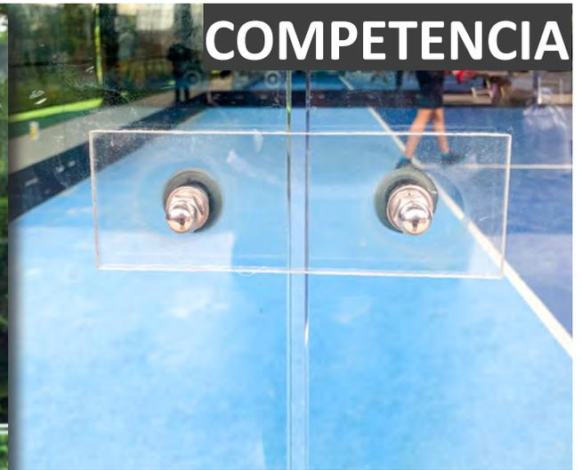
BLACK BOX utiliza uniones de nylamid y silicón entre los cristales para mantener la correcta distancia entre ellos y dar soporte lateral. La competencia solo usa silicon de una manera muy sucia.
