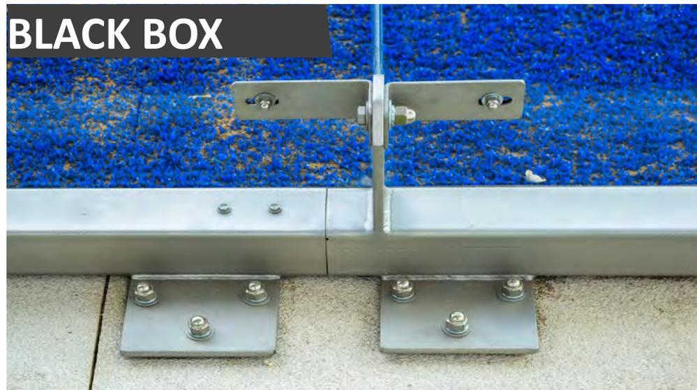
Las canchas de pádel están construidas con cristales templados de 2m de ancho x 3m de altura, es por eso que requieren los mejores herrajes de apoyo en su base y en la parte superior. **Cristales de 3 metros de altura requieren un soporte firme.**
